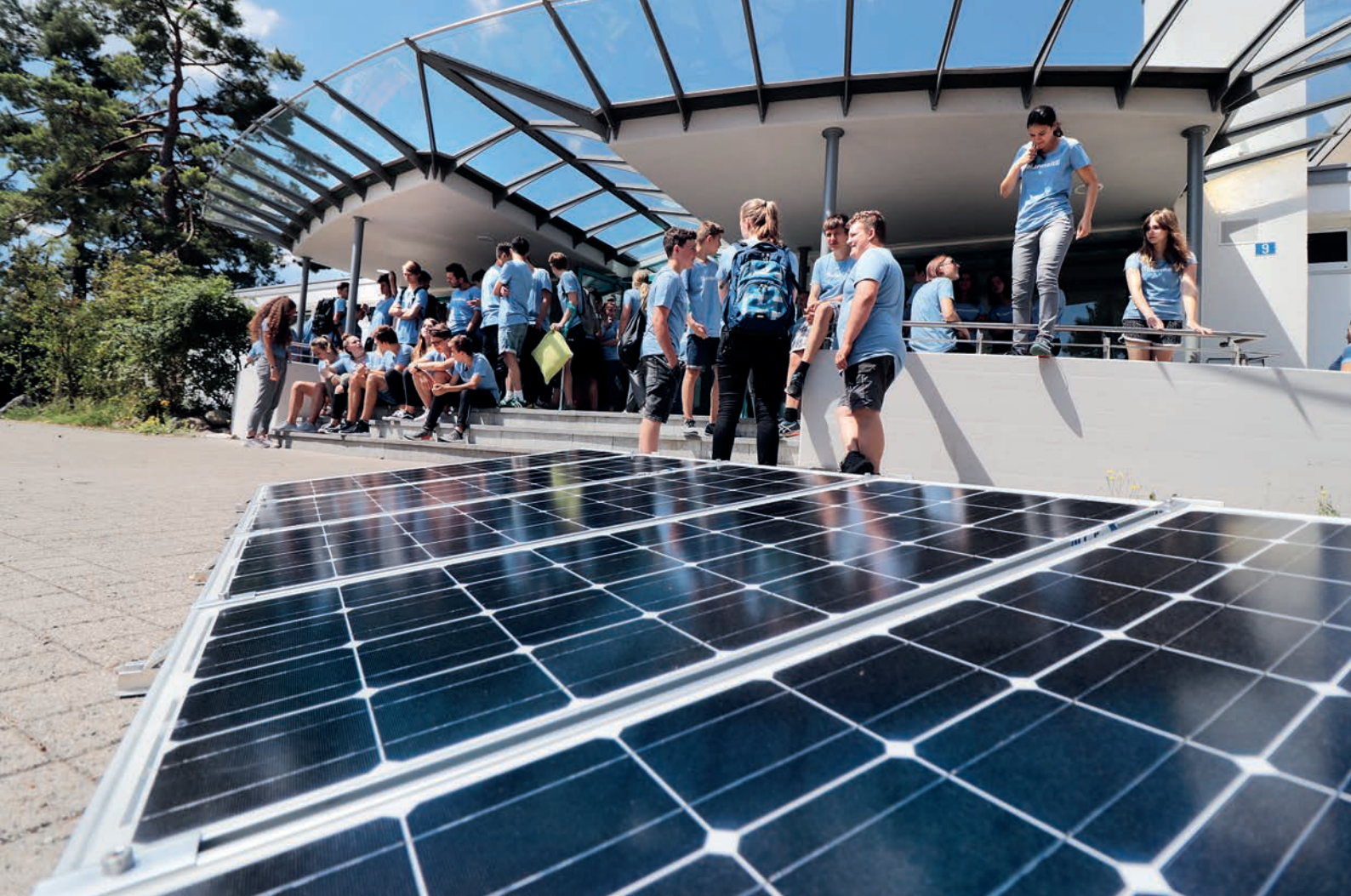
Jede Zelle zählt: Im Juni 2018 konnte die Solaranlage mit Hilfe der Schülerinnen und Schüler auf dem Dach des Schulhauses montiert werden.
