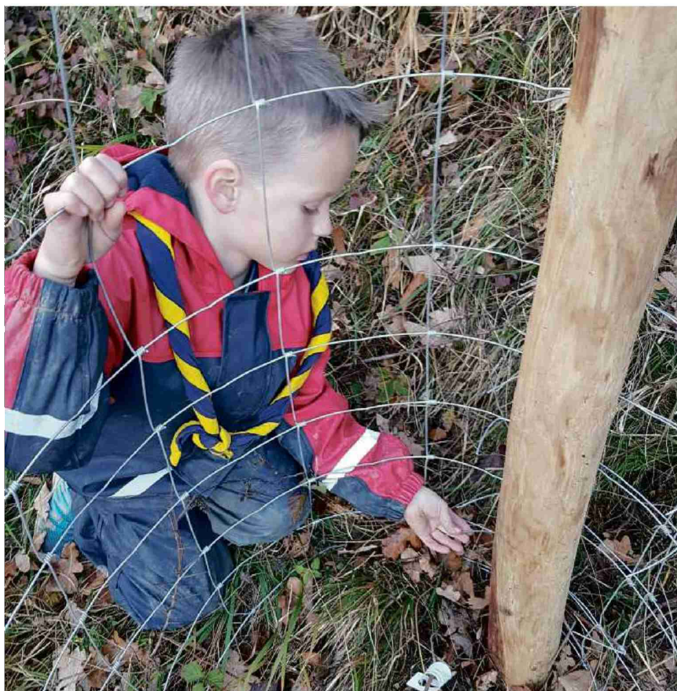
Die abstehenden Gitter werden zum Schutz der Tiere nach innen gebogen.
