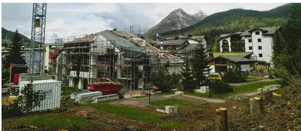
Zwei Fliegen mit einer Klappe schlagen: Beim Waldhuus wird im Zuge der Dachsanierung gleich noch ein zusätzliches Stockwerk gebaut.
